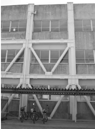
小野南中学校の耐震化工事
