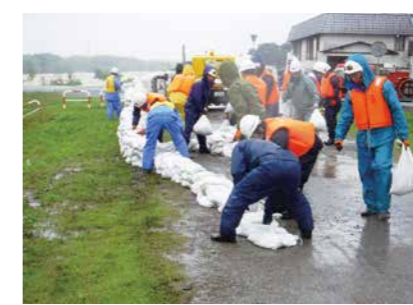
平成30年7月豪雨での水防活動（大門橋）
