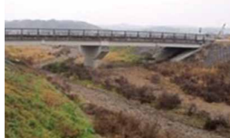
万勝寺川下流部
