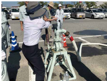
耐震性貯水槽による訓練(大池総合公園)
