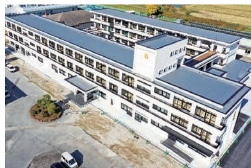
長寿化改良工事が完了した旭丘中学校校舎
