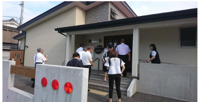
掛田高齢者住宅
