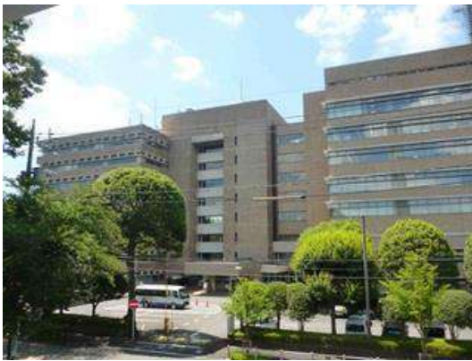
【隣接する市役所庁舎】
