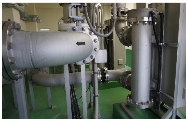
市場浄水場紫外線処理装置
