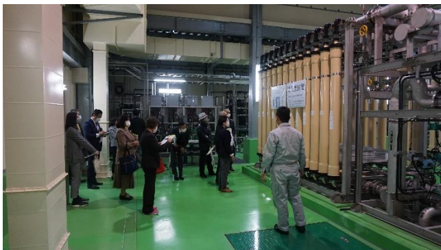
船木浄水場膜ろ過装置
