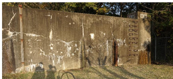
老朽化が進む河合配水池
