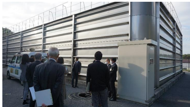
焼山配水池ステンレス製配水池
