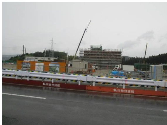
消防庁舎（仮設庁舎より）
