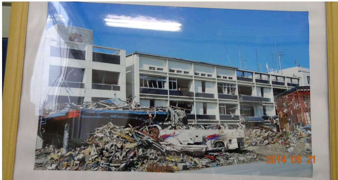
被災した当時の市役所
